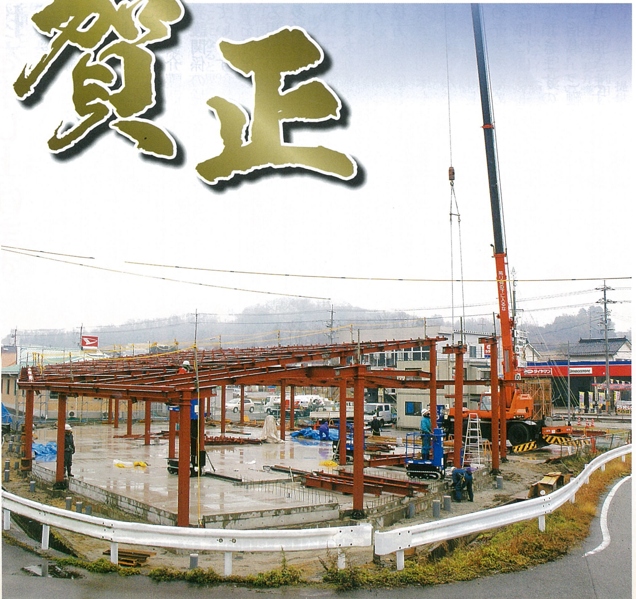
第2ハートウイング西館建設現場
